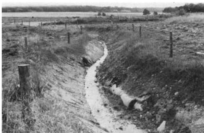
Fig. 36. Il canale Enggård Bæk (Danimarca), in passato intubato, viene riportato a cielo aperto, con un tracciato sinuoso.
