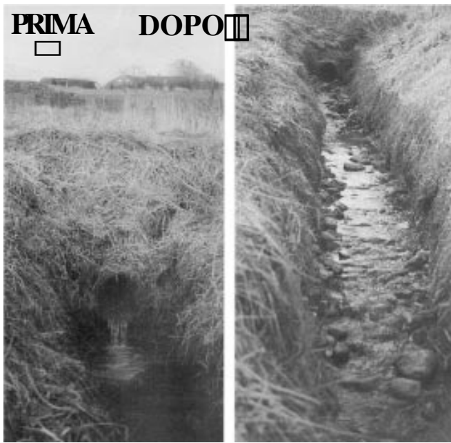
Fig. 34. Rampa in pietrame (a destra) per migliorare l'accesso dei pesci allo sbocco di un tratto intubato mal concepito (a sinistra).
