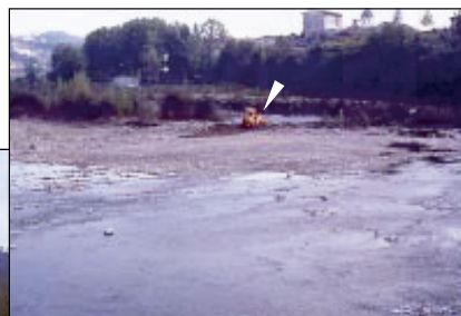
Fig. 7. Lo spianamento dell'alveo (sopra) che accompagna la devegetazione (la freccia indica la ruspa) fa sì che, in condizioni di piena (a sinistra), la corrente sia uniforme ed elevata (come s'intuisce dall'uniformità delle increspature della superficie). I pesci, privati dei loro ripari, sono costretti ad un enorme dispendio di energie per fronteggiare la corrente e muoiono (talora anche alcuni giorni dopo la piena) per l'accumulo muscolare di acido lattico.
