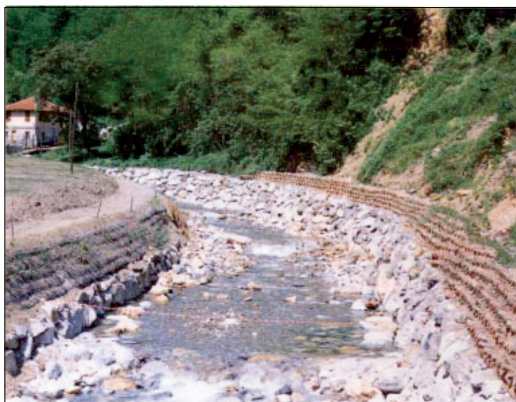
Fig. 13. Esempio da evitare: le scarpate spondali con superficie tendenzialmente piatta, pendenza uniforme e allineamento geometrico riducono la diversità ambientale.
