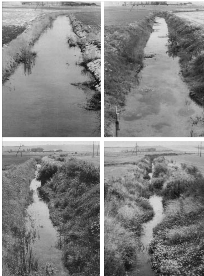
Fig. 32. Al fosso Skiveren (Thisted, Danimarca), tra il 1987 (in alto a sinistra) e il 1990 (in basso a destra), è stata restituita la sinuosità col semplice metodo dello sfalcio di un canale di corrente.
