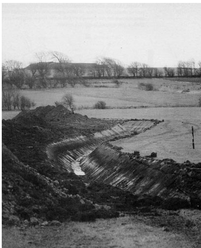
Fig. 37. Scavo di un fosso meandriforme lungo il tracciato del canale Isholm Landgrøft (Danimarca), precedentemente tombato.
